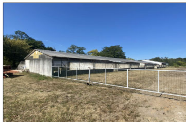
Vue 4 - Bâtiment existant - Accès aux parcs de détente
