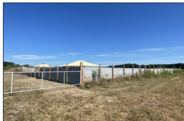
Vue 5 - Parcs de détente en cours d'aménagement
